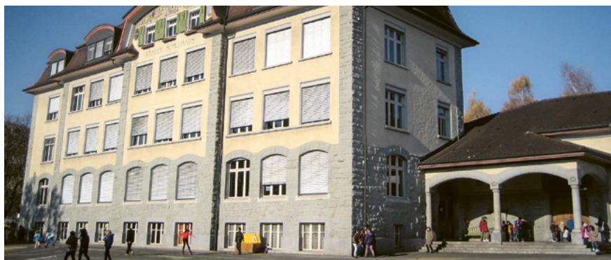
Alte Heizung, schlechte Dämmung, fehlender Platz: Das Schulhaus Krauer muss saniert werden.
