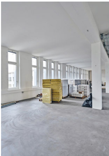
Einblick in die sanierten Räumlichkeiten im Sektor B.
