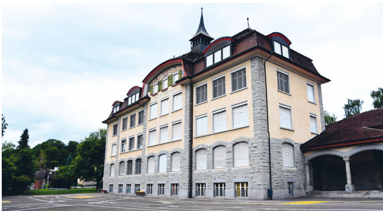
Alte Heizung, schlechte Dämmung, fehlender Platz: Das Schulhaus Krauer wird im Rahmen einer Teilsanierung auf Vordermann gebracht.
