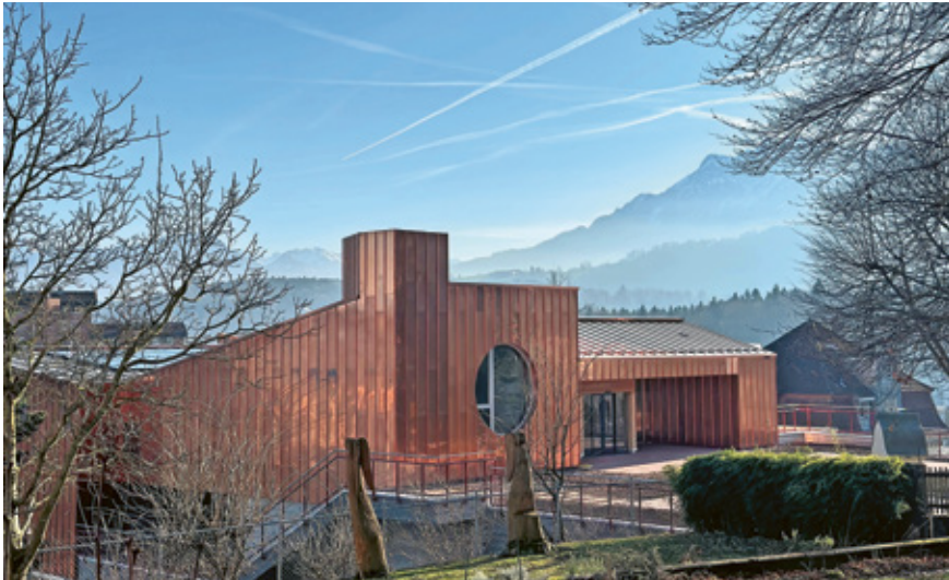
Das über 40-jährige Pfarreizentrum Gerliswil wurde saniert und erweitert und wird nun feierlich neu eröffnet. (Bilder: PD)
