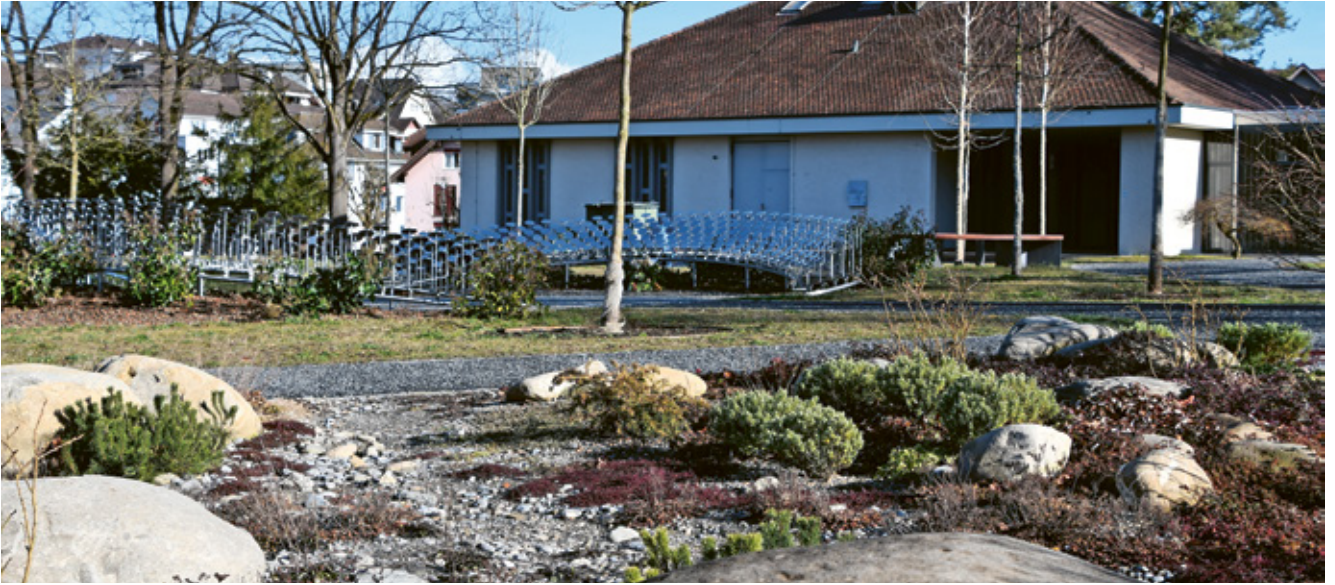
Im mittleren Friedhofsbereich können Verstorbene neu mittels Baumbestattung oder im Alpinum beigesetzt werden. (Bild: pbi)
