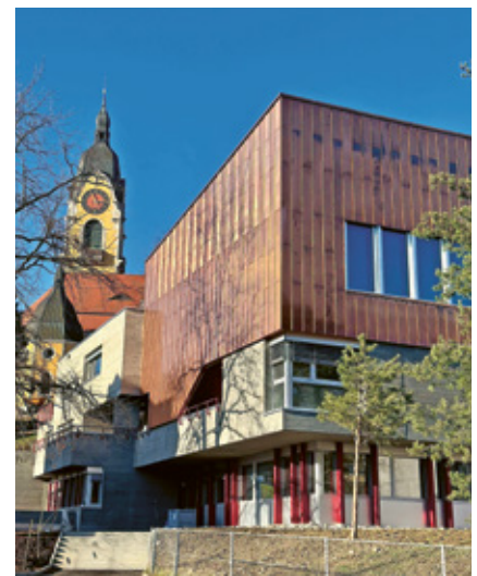
Das bestehende Pfarreizentrum wurde mittels Aufstockung erweitert.
