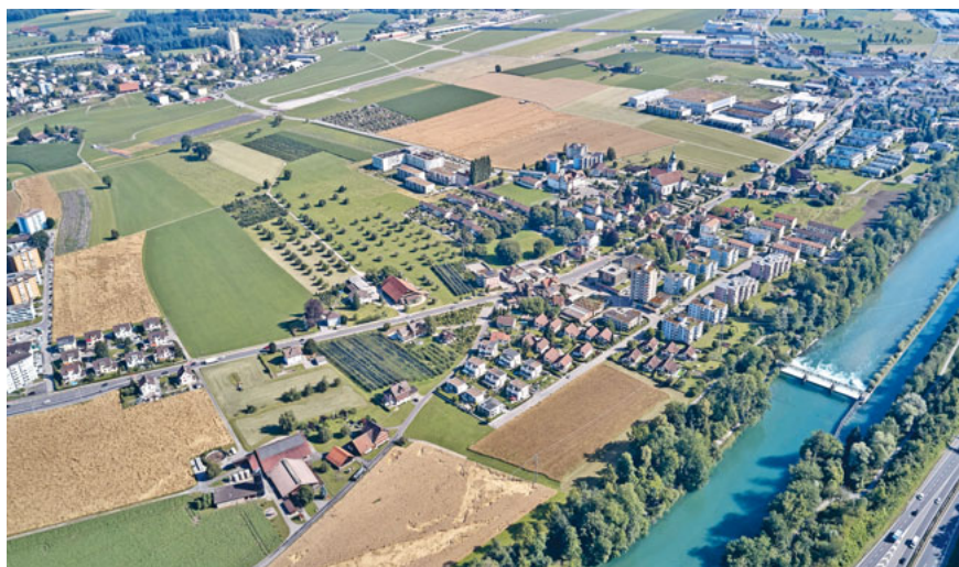
Entlang der Seetalstrasse in Emmen Dorf soll die Verkehrssicherheit erhöht, die Erreichbarkeit sichergestellt und der Verkehrsfluss verbessert werden. (Bild: Gemeinde Emmen)
