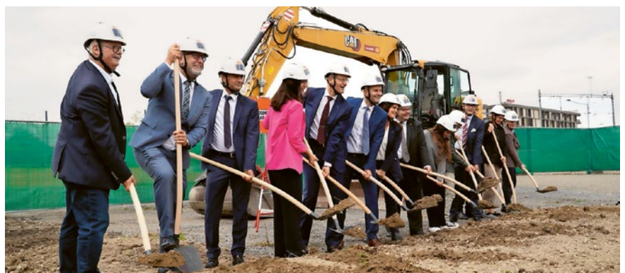
Mit dem Spatenstich ist der Baubeginn am Seetalplatz offiziell eingeläutet. (Bild: PD)
